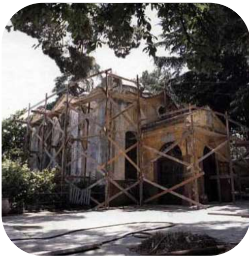
Κατά την ανέγερση του ναού
